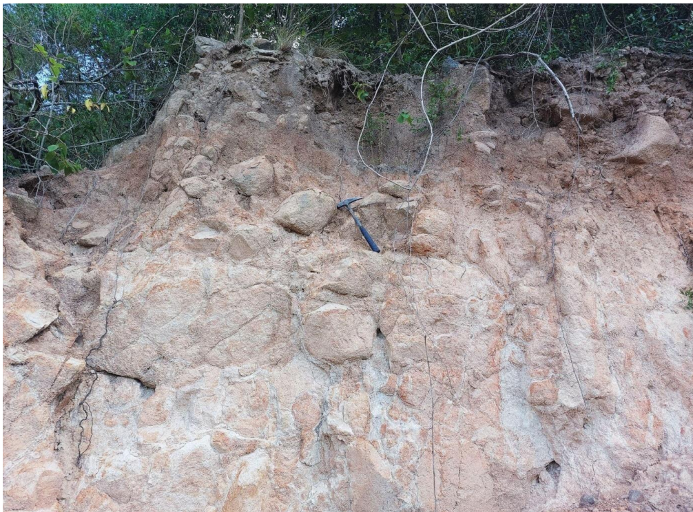
Figura 7. Perfil de meteorización de la cantera CONTEC. Corestones dentro del perfil.
