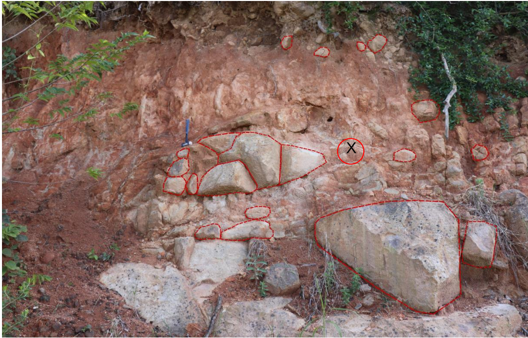
Figura 23. Zona de muestreo de la Cant 3. Se observan corestones marcados con líneas discontinuas rojas.
