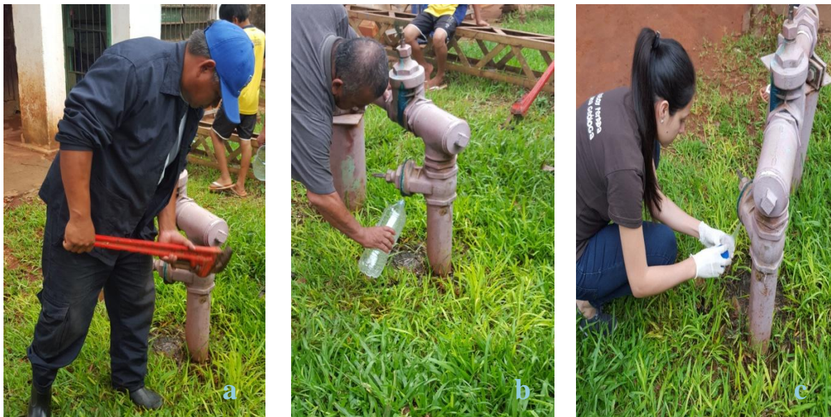
Anexo 10: Toma de muestras del Pozo n° 3 P0054; a. Abertura de cañería para obtención de muestra b. Muestreo para análisis físico-químico c. Toma de muestra para análisis bacteriológico
