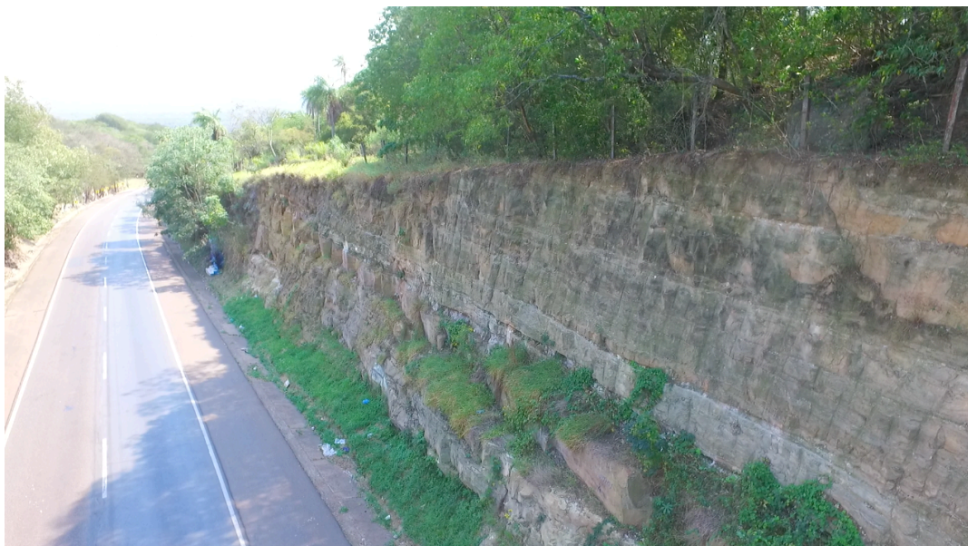
Figura 23. Cobertura vegetal en el pie y pendiente del Talud del Cerro Caacupé Fuente: Elaboración propia
