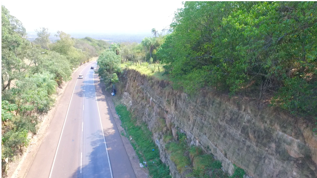
Figura 13. Fotografía tomada con el drone , vista al carril de descenso del Cerro Caacupé y del talud.
