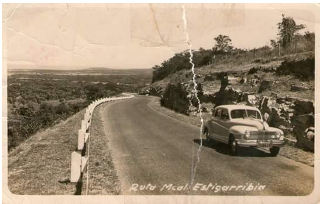
Figura 2. Fotografía de la década de los 70 de la Ruta PY02 tramo carril de ascenso Cerro Caacupé.
