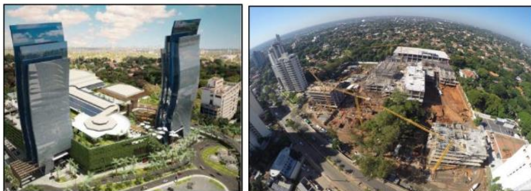
Figura 8: Edificios del Paseo La Galería, imagen virtual e imagen de obras en 2015 Fuente: Obras geotécnicas en el Paseo La Galería, Asunción, Paraguay. (Arroyos, F., et al. 2015)
