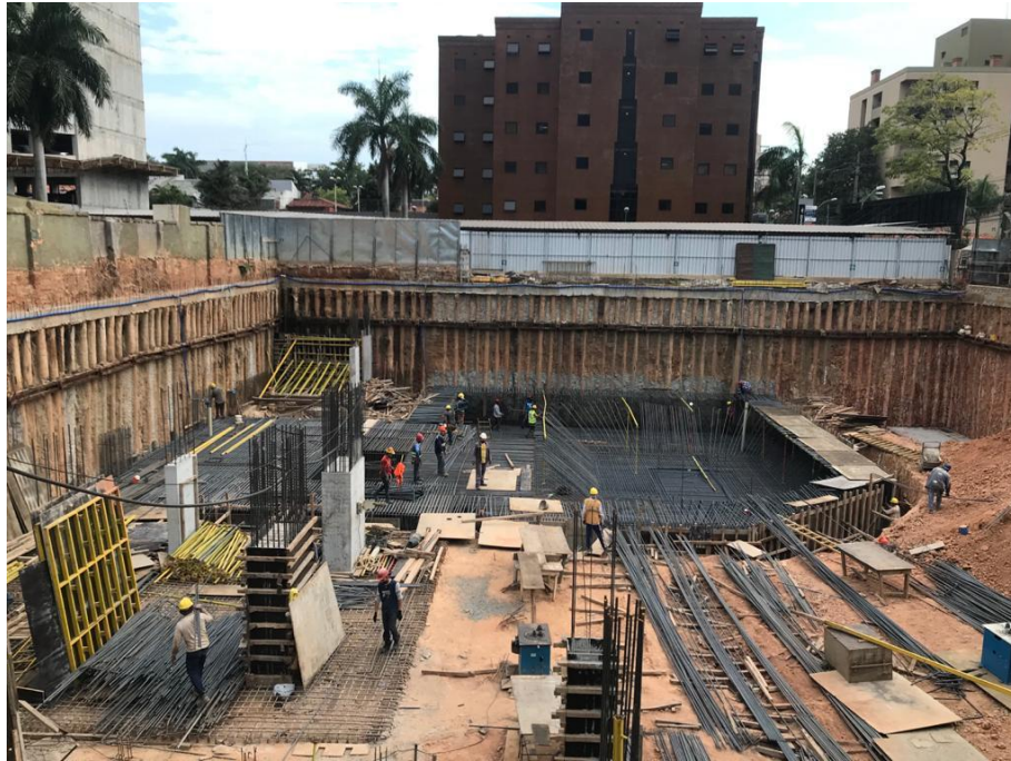
A 5. Avances en la construcción del 1er nivel del subsuelo.
