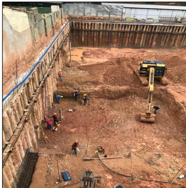
Figura 12: Pantalla de micropilotes de la obra Fuente: (Ing. F. Mencia, comunicación personal, 13 de abril 2021).
