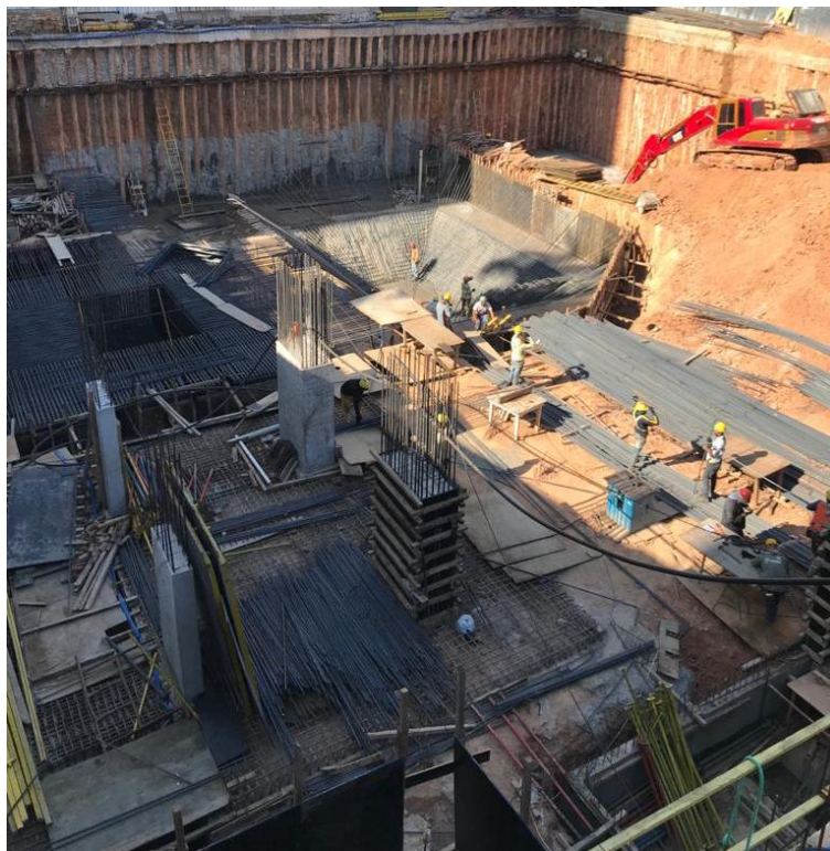
A 6. Avances en la construcción del 2do nivel del subsuelo.
