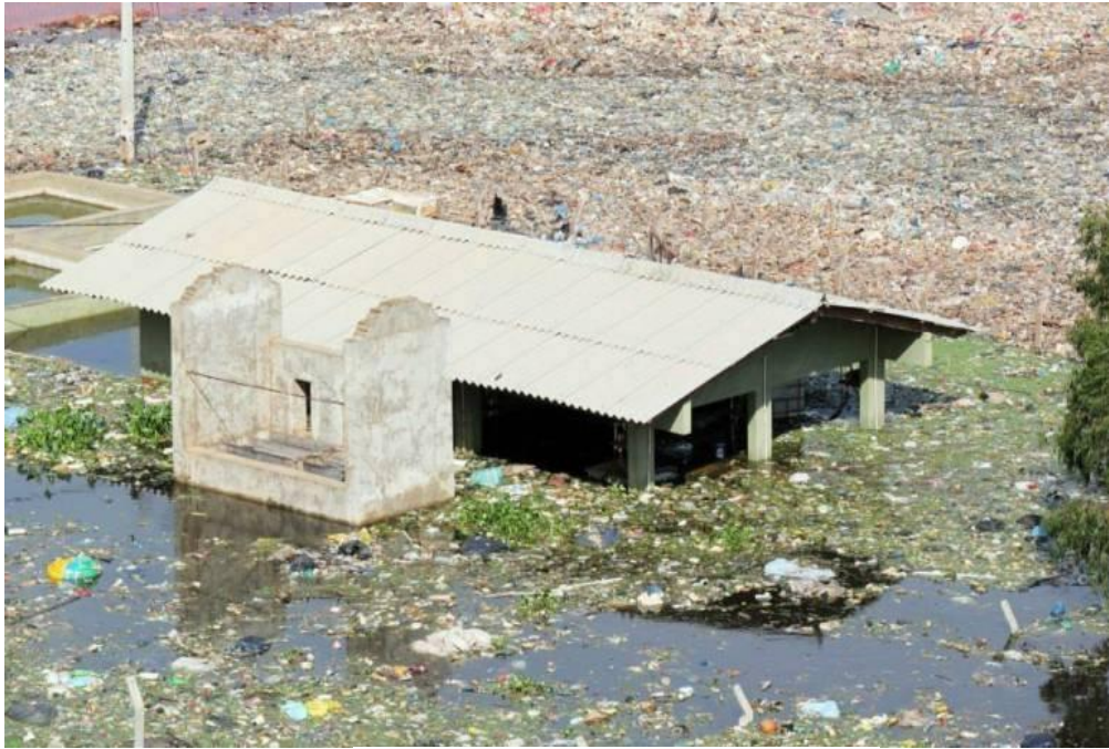
Figura 2. Inundación en el Vertedero Cateura.
