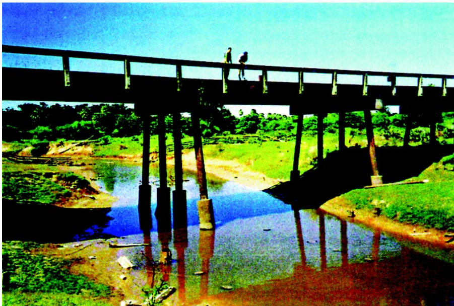
Medición del nivel del agua desde la baranda del puente
