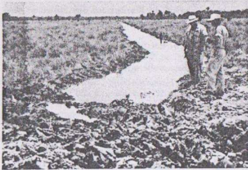
Abb. 16. Ende der Bauphase 1957 durch Wolkenbruch bei km 51 der Trans-Chaco-Straße. Salzhaltiger Lehm wurde für Wochen unpassierbar
